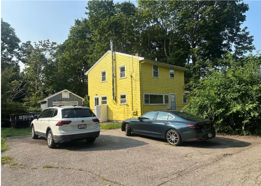
40A Hersey Street (Subject Property)
